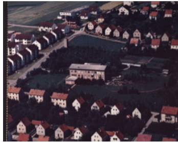
Luftbildaufnahme 1968, Ausschnitt „Krankenhaus“
