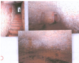
Inneres des „Glaserkellers“ (3,3 m Höhe, 5,6 m Breite, 8,8 m Länge), Grundriss
