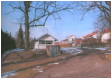
Beratzhausener Straße 45, Blick auf den „Glaserkeller“, 2009
