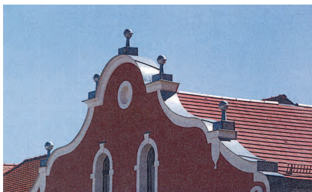
Natürlich ist Blech hier unverzichtbar, wie für die Erneuerung des platzbildprägenden Schweifgiebels. Für das Hauptdach war die naturrote Biberschwanzdeckung aber eine Selbstverständlichkeit.
