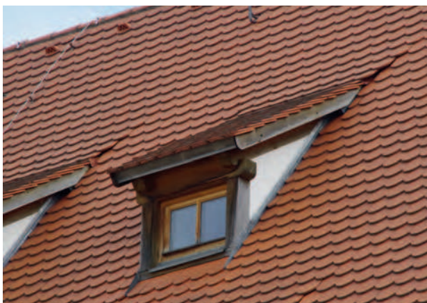
Ein „klassisches“ (Biberschwanz-)Dach für die Hemauer Altstadt am Zehentstadel!
