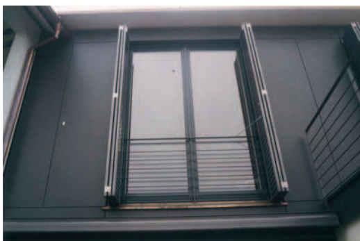
Der 2-flügelige Klappladen hier am Beispiel eines franz. Balkons kann eine elegante Alternative zum Rollladen sein.
