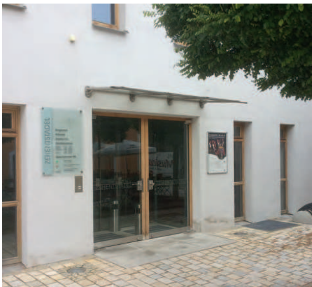
Ein etwas eleganterer Wetterschutz in Glas, der in der Fassade kaum Spuren hinterlässt.
