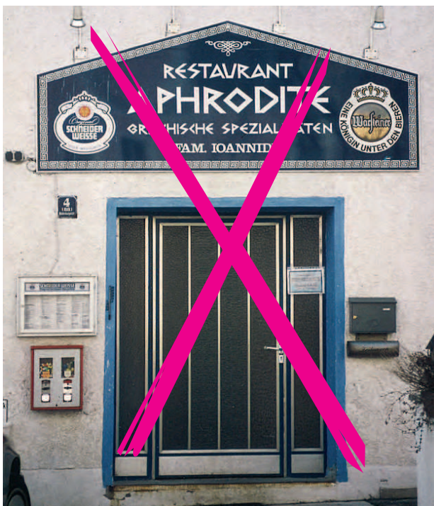
Werbetransparente sind immer auch ein Eingriff in die Fassade.
