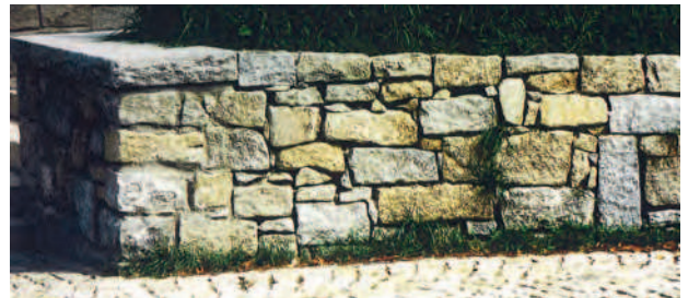
Niedrige Sockelmauern empfehlen sich als Natursteintrockenmauerwerk.
