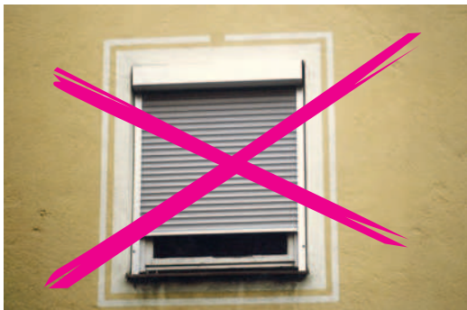
Im Hemauer Stadtkern unerwünscht: größerformatige Einscheibenfenster mit nicht integrierten Rollläden.
