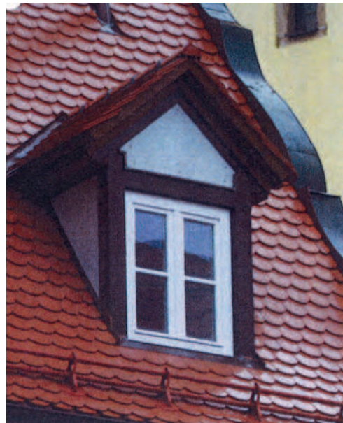
Ausgewogen ausgeführte Stehgaube mit vorgelagertem Gestängeschneefang.
