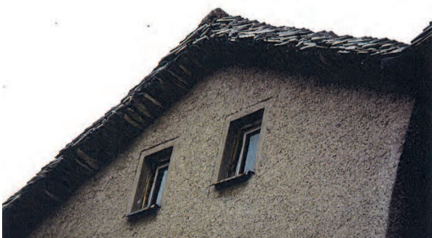
Ganz verschwinden darf das Jura-Dach nicht aus dem Hemauer Stadtbild – es ist auch ein Alleinstellungsmerkmal der Stadt. Nur das Steindach legt sich wie ein Mantel über die Gebäude, alle anderen Dachdeckungen bedeuten lediglich eine Dachhaut.
