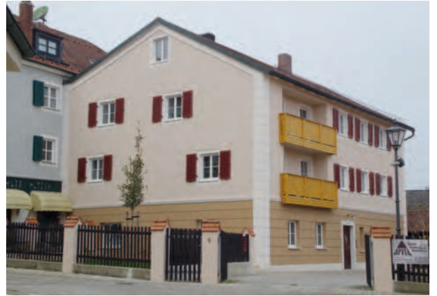
Das erfreuliche Ergebnis der Fassadenerneuerung.
