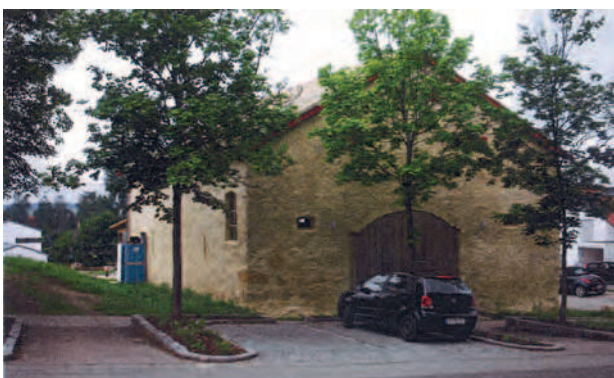
Ein Beispiel, das Hoffnung macht: die Sanierung des Weismannstadels mit Kalkplattendach. Mittlerweile gibt es wieder ausreichend Spezialisten, die Kalkplattendächer sach- und fachgerecht erstellen (und sanieren) können.
