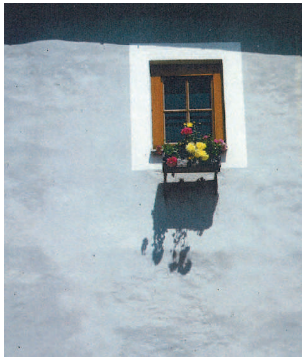
Aktuell geht der Trend zu glatten Putzen – auch die lassen sich handwerklich in überzeugender Form herstellen, wie hier bei dem frei aufgetragenen Kellenglattstrich.
