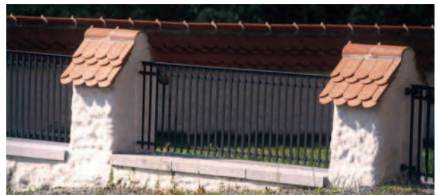
... aber auch mit geputzten Zaunsäulen.
