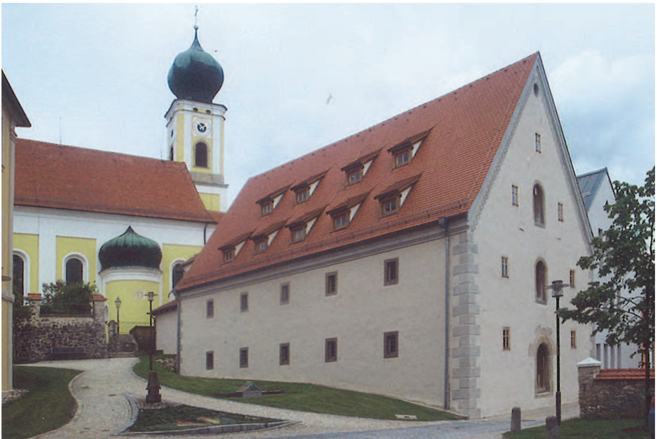
Ein „klassisches“ (Biberschwanz-)Dach für die Hemauer Altstadt am Zehentstadel!
