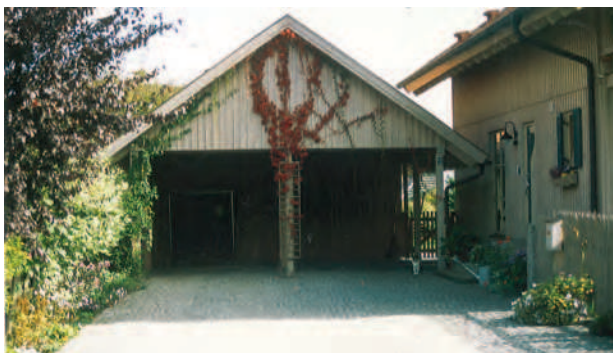
Wo immer der Platz reicht, sollten Garagen als eigenständige Baukörper mit Satteldach vorgesehen werden. Ein vorgelagerter gedeckter Stellplatz/Carport kann dabei die Proportion des Garagenbaus noch verbessern.
