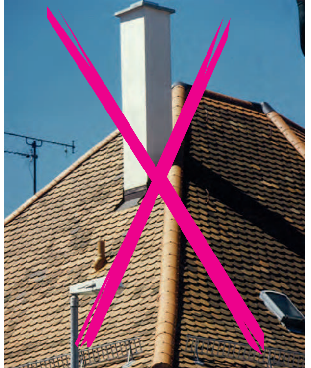
Unglücklich proportionierter und schlecht situierter Außenkamin.
