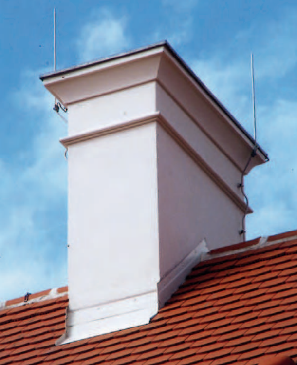
Gut gestalteter und richtig (im First) platzierter Kaminkopf.
