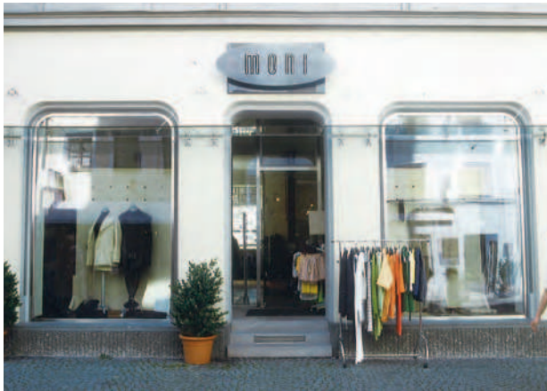
Einfaches Glasvordach über einem Geschäftseingang.
