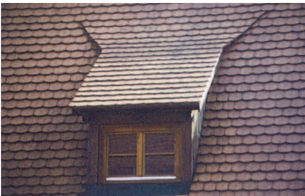
Gelungene Gauben sind immer auch handwerklich anspruchsvolle Details. Die Einbindung der Biberschwanzdeckung in die Dachfläche ist hier mustergültig.
