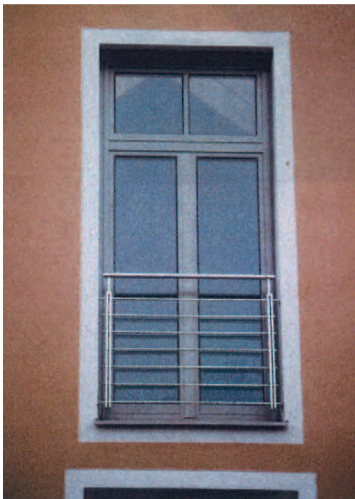
Von hoher Bedeutung für das Straßenbild der franz. Balkone ist die Ausbildung der fassadenbündigen Brüstung, die möglichst unauffällig und filigran ausfallen sollte, wie bei den beiden Schlosserarbeiten dieser Seite. Barocke Schmiedeeisen-Prachtentfaltung gerät hier leicht zur Karikatur.
