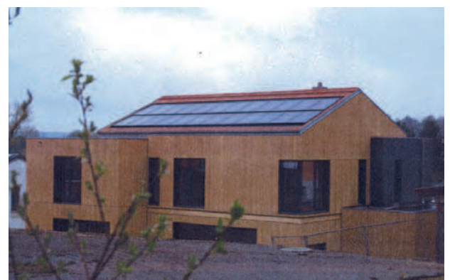
Außerhalb der geschlossenen Bebauung sind Solaranlagen vor allen Dingen dann unbedenklich, wenn sie – wie hier bei diesem Beispiel – in die Dachfläche integriert sind. Dies bedarf einer frühzeitigen Überlegung.
