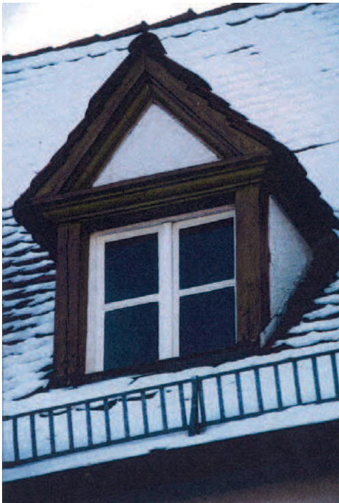
Gut gestaltete Stehgaube mit vorgelagertem Leiterschneefang.
